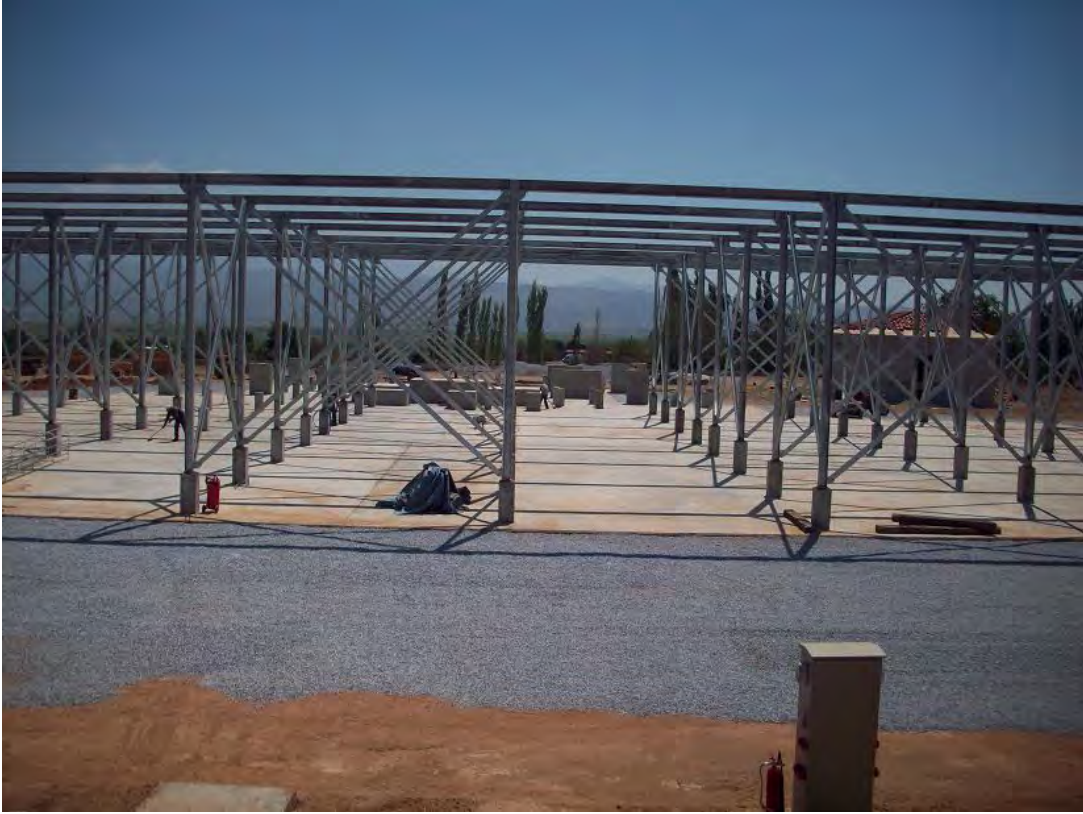
Resim.2. Proje inşaat aşamasından bir görünüm.
